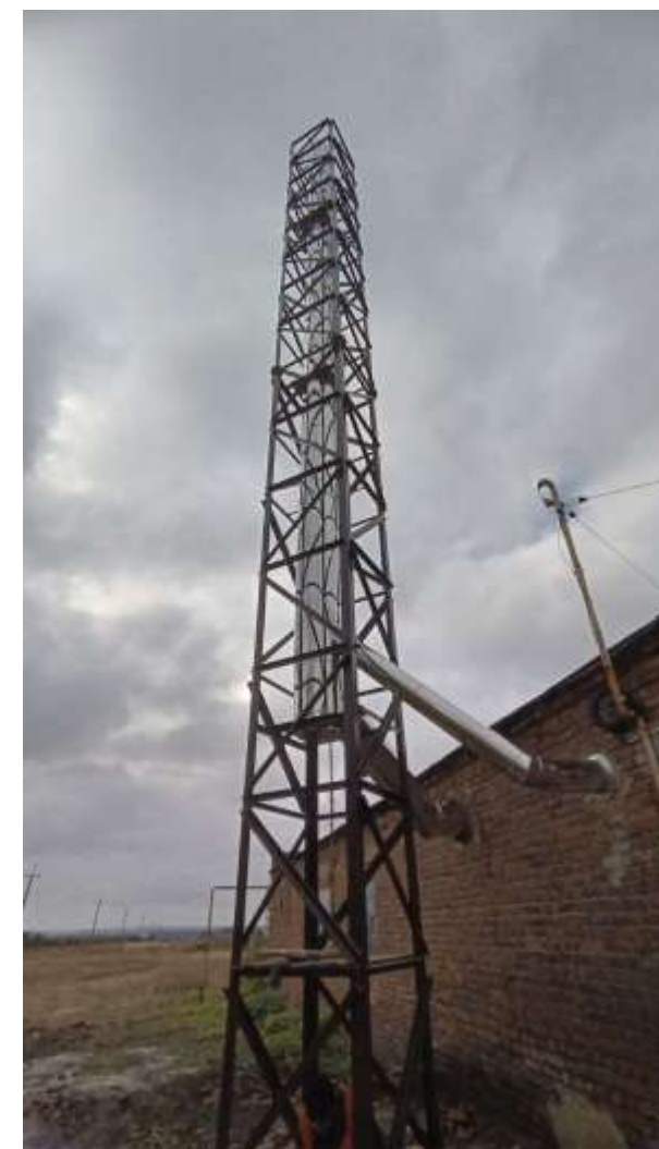
Заміна димохідної труби в Кам'яноярському ліцеї
