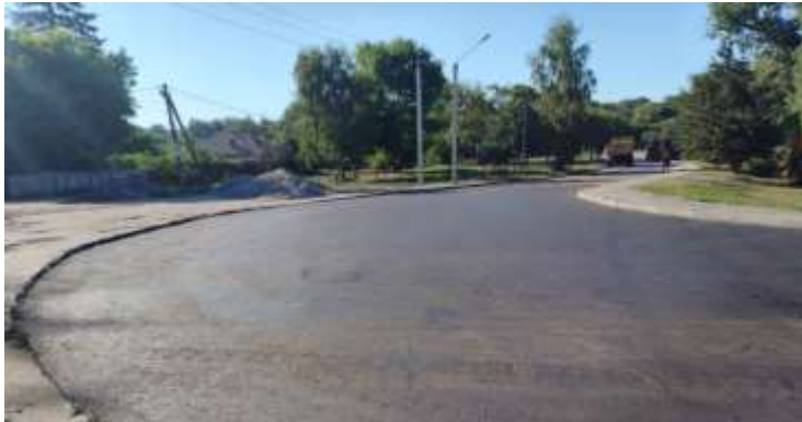
Капітальний ремонт дороги по вул. Осинівська
