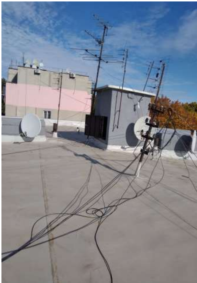
Ремонт покрівлі, вул. Литвінова, 49 у с-ще Кочеток
