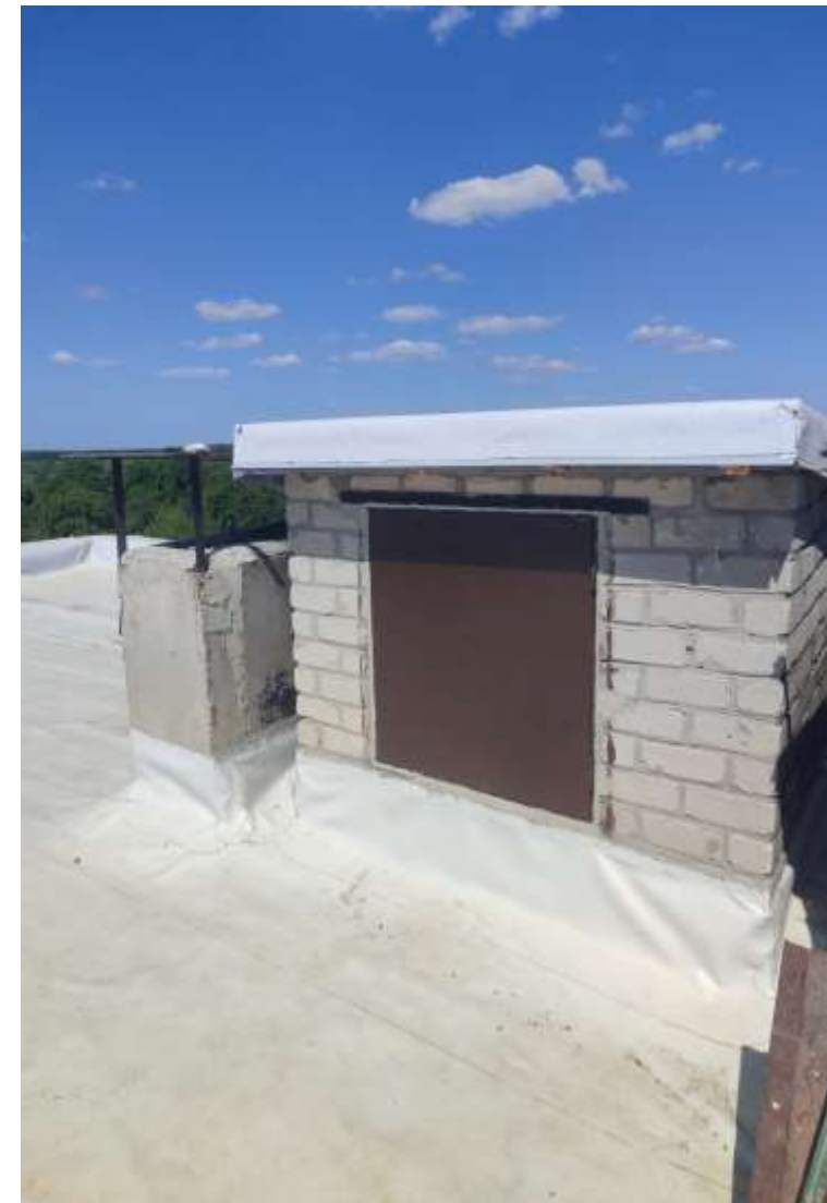
Ремонт покрівлі, вул. Миру, 2А у с-ще Кочеток
