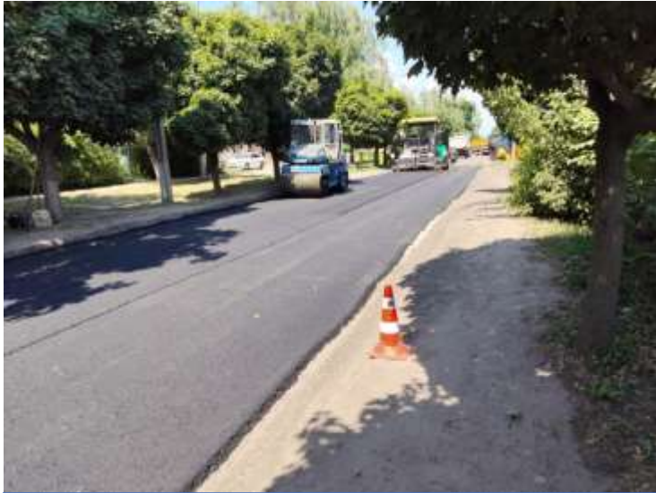
Капітальний ремонт дороги по вул. Гвардійська
