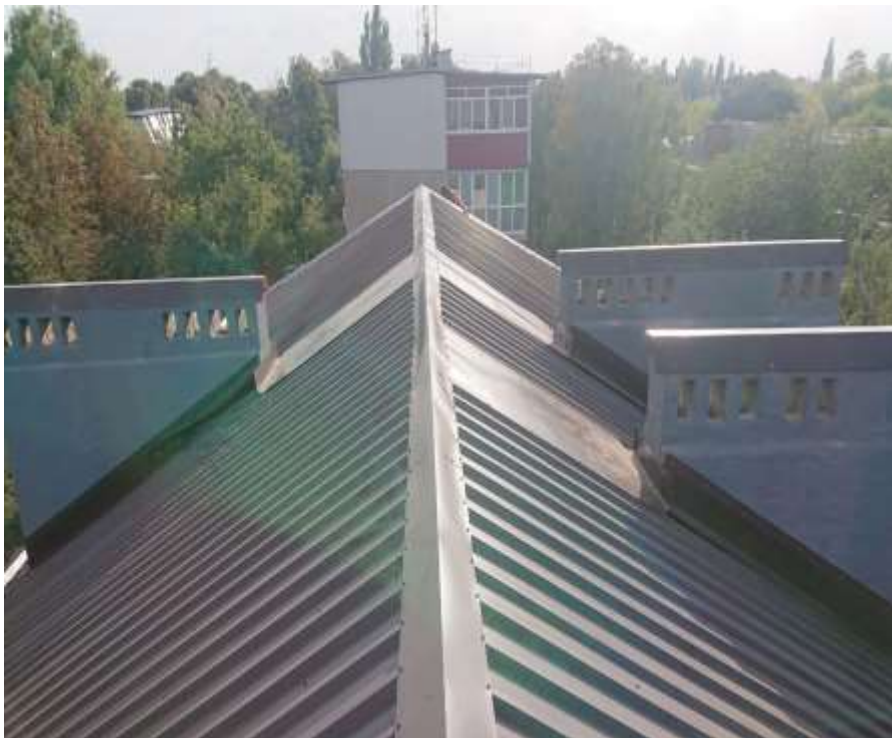
Ремонт покрівлі, м-н Авіатор, 154 в м. Чугуєві
