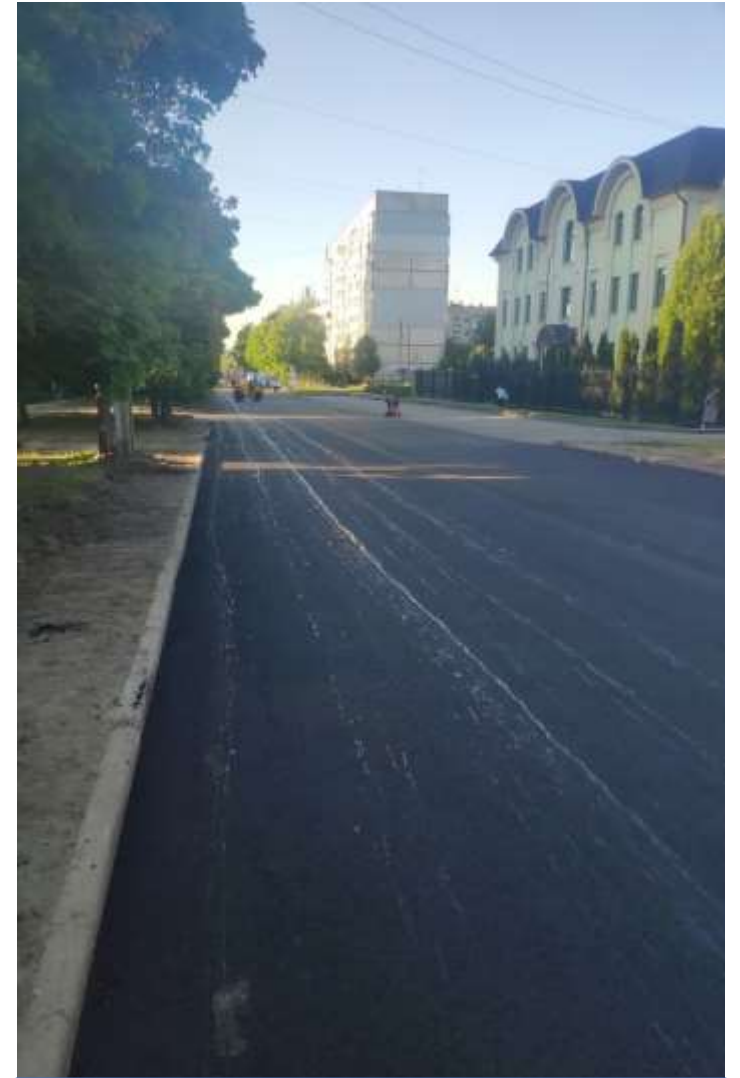
Капітальний ремонт дороги по вул. Харківська
