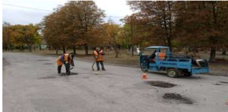
Ямковий ремонт по вул. Пірогова
