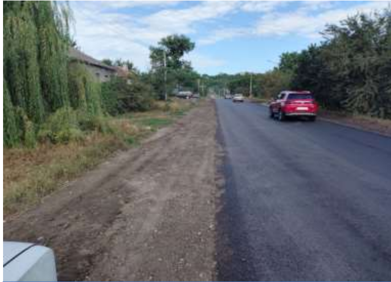
Капітальний ремонт дороги по вул. Підгірна
