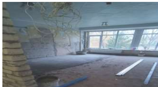
Аварійно-відновлювальні роботи в ліцеї №8
